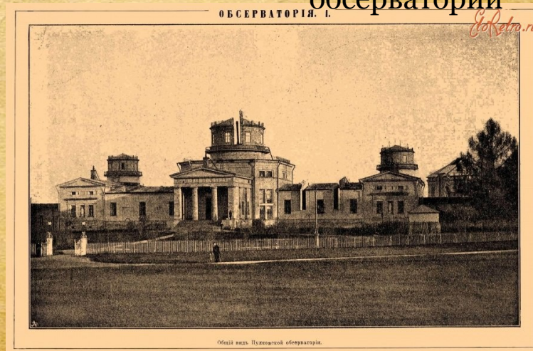
Строительство Пулковской обсерватории
